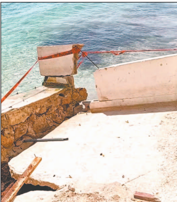
El mar socavó los escalones y existe riesgo de derrumbe. (POR ESTO!)
