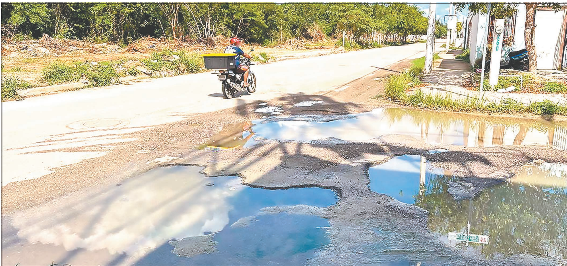
Dieron a conocer que aparentemente el desagüe de los patios y las cocinas no cuentan con drenaje subterráneo, situación con la que lidian desde hace 10 años. (POR ESTO!)
