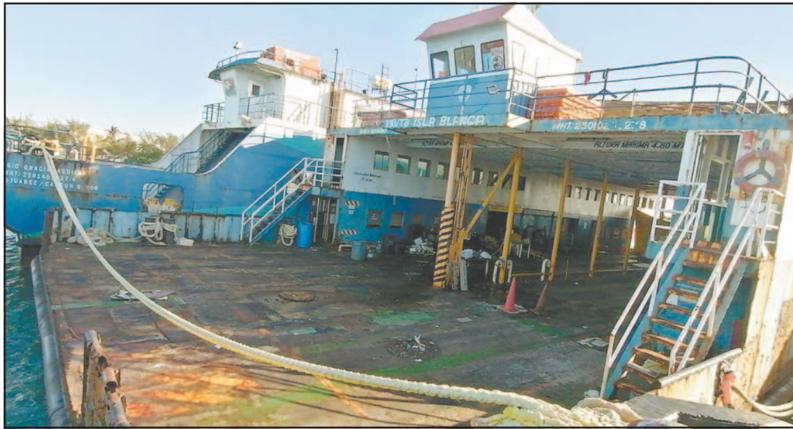
Debido al desgaste que presenta en la cubierta y escaleras, recomendaron desmantelar la unidad. (O. López)
