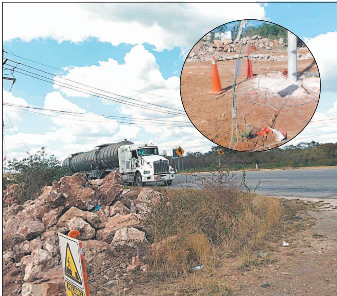
El choque causó el descenso de las líneas de alta tensión, afectando a Hochtún, Tahmek y a este municipio.
