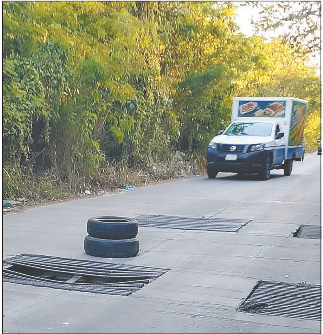
Un habitante colocó par de llantas para que los conductores puedan ver el peligro. (Williams Duran)
