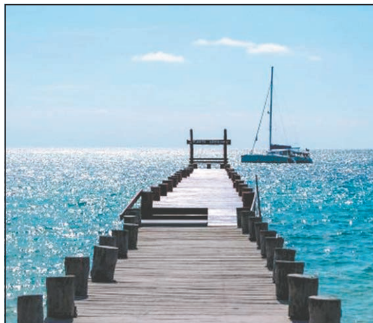
Diagnósticos arrojaron daños debido a la salinidad del mar. (POR ESTO!)
