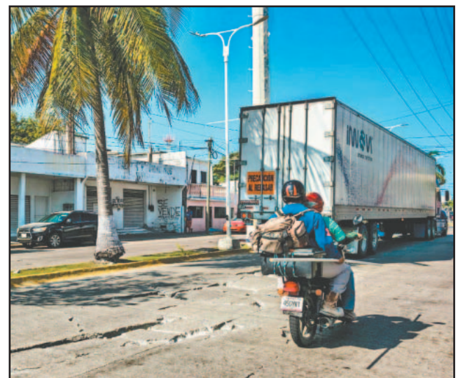
CIUDADANOS se dicen preocupados por el deterioro de la Avenida 10 de julio, que presenta un socavón y fractura en las losas.- (Perla Prado)
