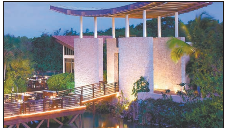
Los trabajos empezaron desde el 2021 sin contar con los permisos.
