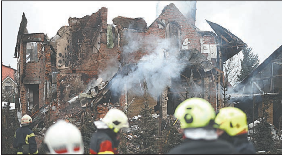
En el suburbio de Sofiyvska Borshchagivka hubo daños a varios edificios. (AFP)
