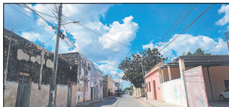
Habitantes temen que si no se arreglan las líneas haya apagones .
