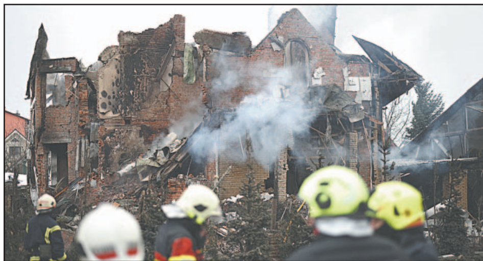
En el suburbio de Sofiivska Borshchagivka hubo daños a varios edificios. (AFP)
