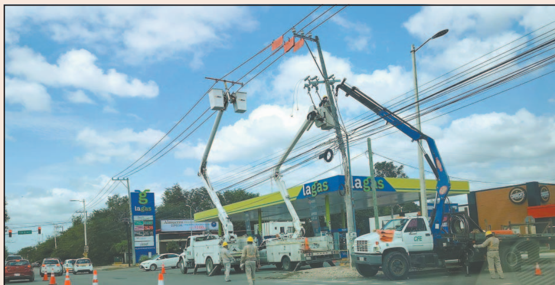
Ayer, la estructura se estuvo balanceando peligrosamente debido a los fuertes vientos. (W. Duran)
