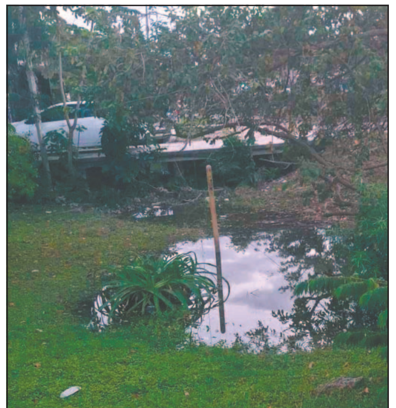
Vecinos pidieron reparar la falla en la calle 32 con Av. 7. (POR ESTO!)
