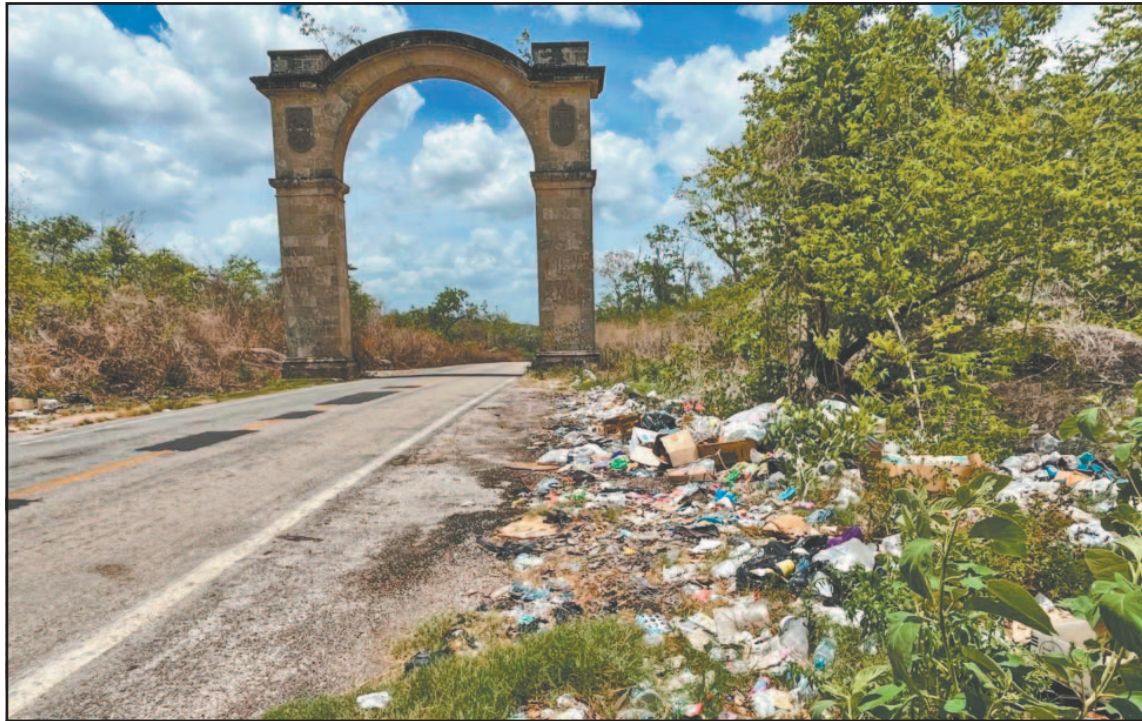
Además de la falta de atención, a un lado del camino se ha generado un basurero clandestino. (M. Koh)
