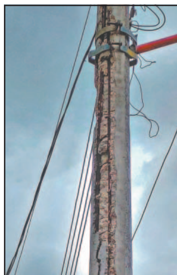
Las varillas expuestas podrían causar accidentes. (Mauriel Koh)
