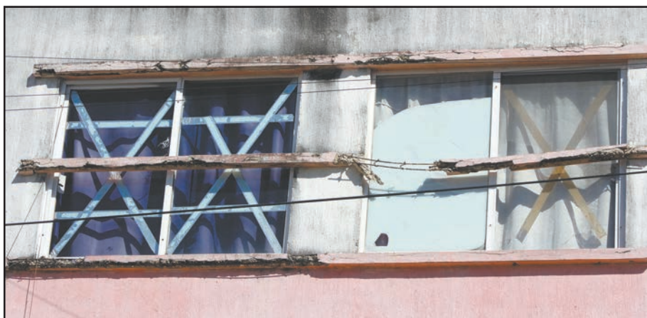
Carencia de mantenimiento causó la aparición de las varillas en los muros exteriores.
