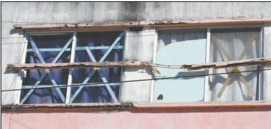
Carencia de mantenimiento causó la aparición de las varillas en los muros exteriores.
