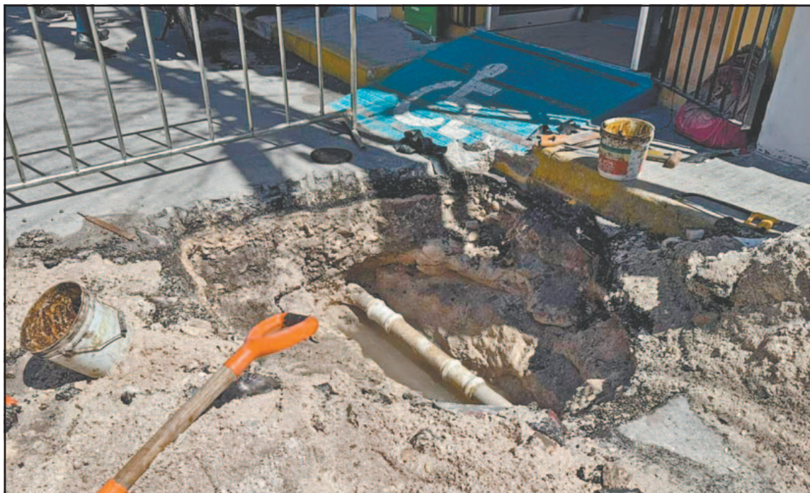
Para reparar la tubería de asbesto debe suspenderse totalmente el bombeo, justificaron los trabajadores.
