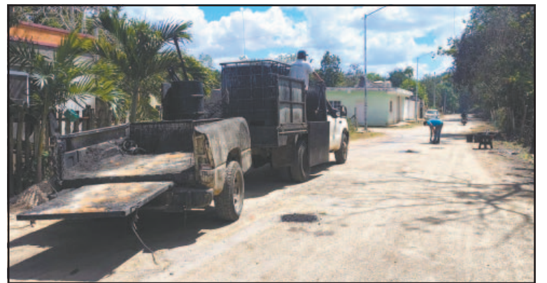
Mototaxistas afirmaron que se requiere repavimentación. (Lusio Kauil)
