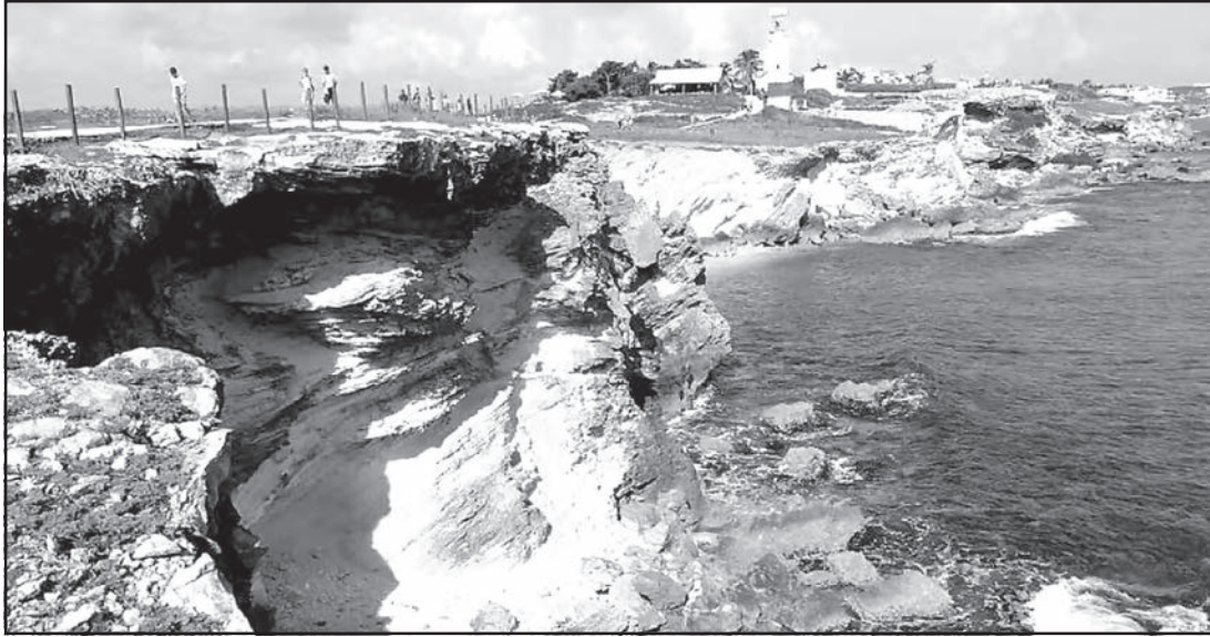
El último desmoronamiento ocurrió el 17 de diciembre pasado, con una afectación de 30 metros. (O. López)
