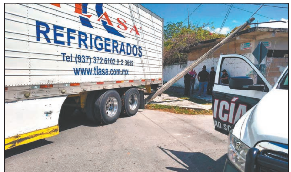
Trabajadores de la CFE quitaron la estructura de concreto y pusieron otra. (Fotos E. Martín)
