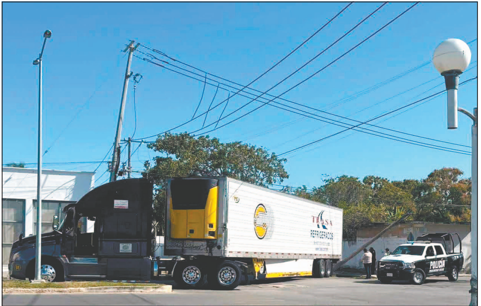
Chofer de un camión realizó un cálculo erróneo y al retroceder golpeó un poste de la Comisión de Electricidad que se desplomó sobre la vía.
