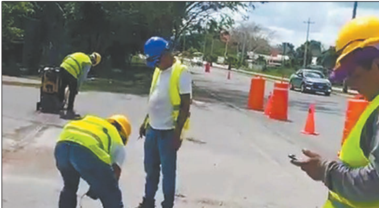
Detallaron que los trabajos consisten en la instalación de semáforos y pasos peatonales en la zona del libramiento. (Fotos POR ESTO!)
