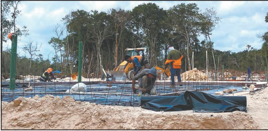
Trabajadores comenzaron la cimentación del primero de 15 edificios residenciales.
