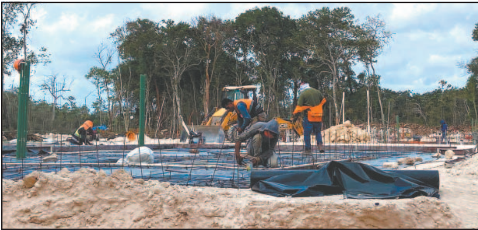
Trabajadores comenzaron la cimentación del primero de 15 edificios residenciales.
