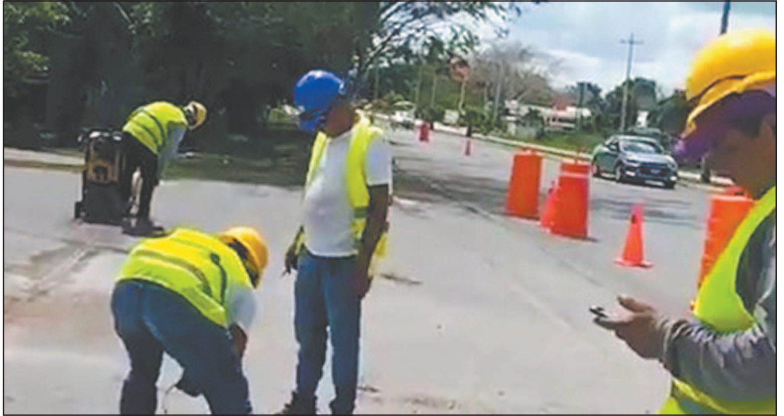
Detallaron que los trabajos consisten en la instalación de semáforos y pasos peatonales en la zona del libramiento. (Fotos POR ESTO!)
