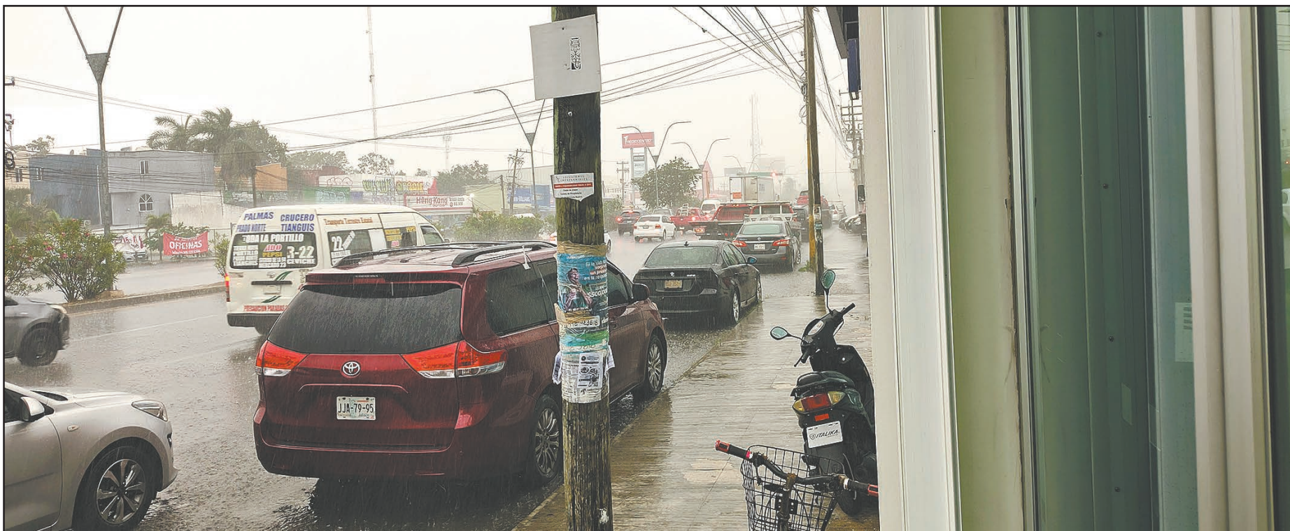
El azolve de pozos pluviales ocasionó que el agua se filtrara de manera lenta y los conductores extremaran precauciones para evitar sufrir un choque. (Fotos R. Flores / M. Chacón)
