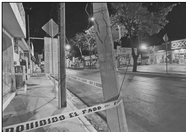
Vecinos ven choque y la fuga del guidor en el barrio de San Román.
