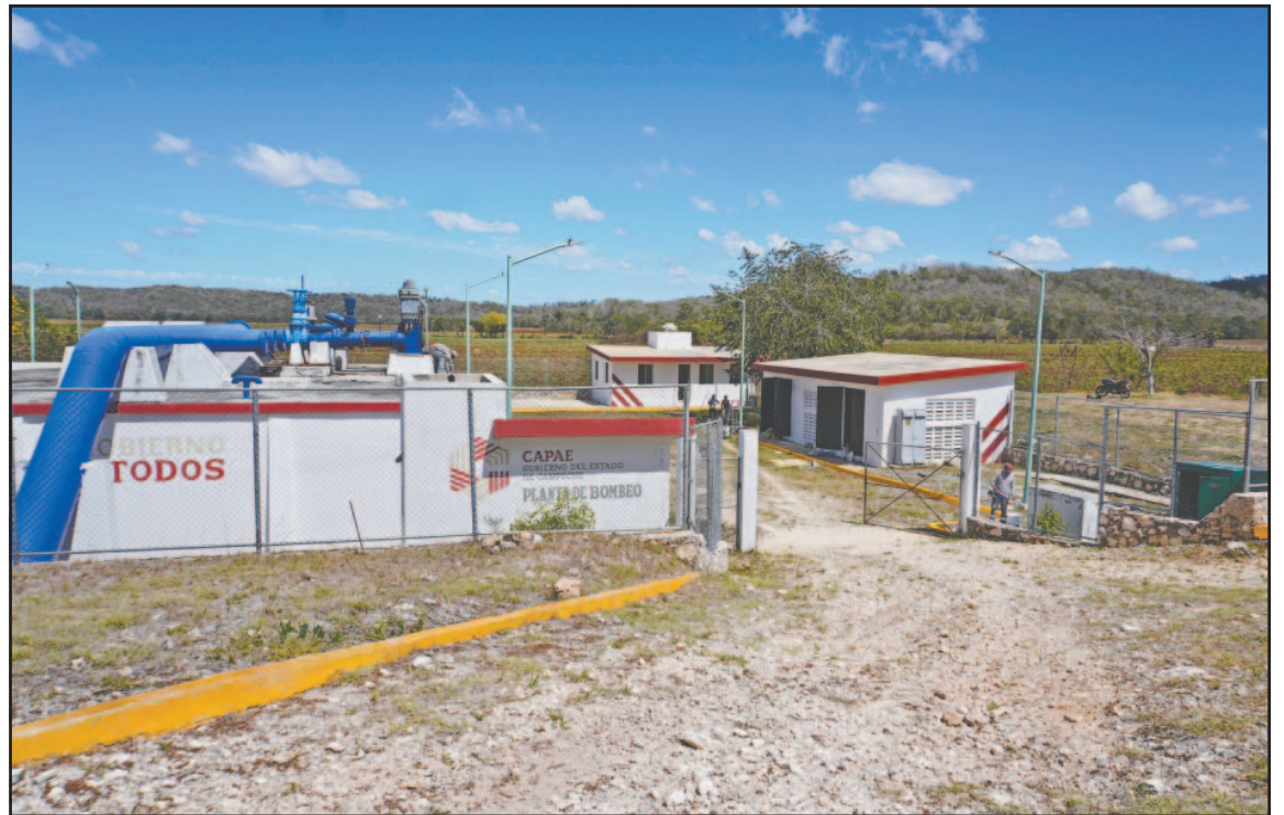
La importante obra hidráulica se encuentra todavía en una fase de pruebas y mejoras. (Lucio Blanco)
