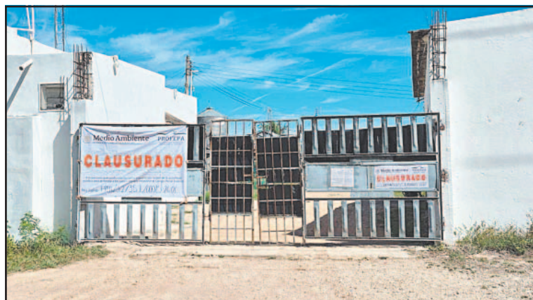
La SDS realiza inspecciones aleatorias, con apoyo de la Profepa.
