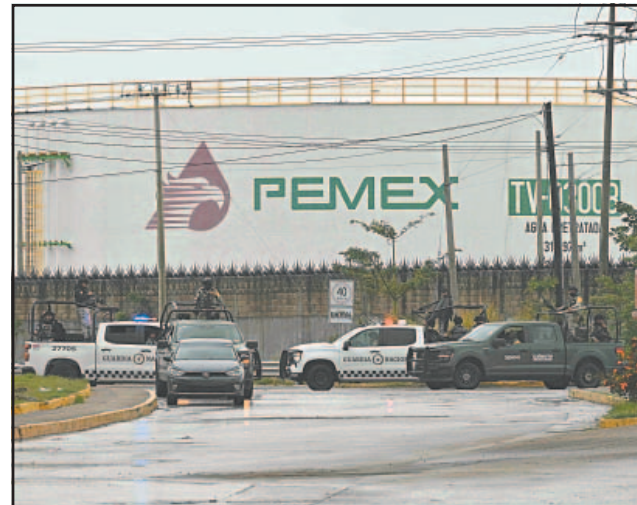
PETRÓLEOS Mexicanos aseguró que el fuego fue controlado sin que se registraran daños en las áreas principales de almacenamiento de hidrocarburos.- (POR ESTO!)
