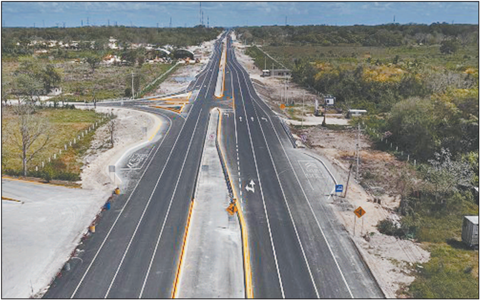
El tramo de seis kilómetros se ensanchará de doce a 23 metros y contará con obras de drenaje y puentes peatonales. (Alejandro Pech)
