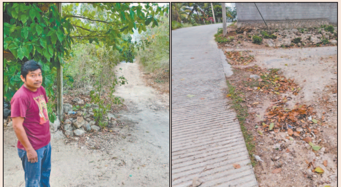
César Salazar mostró el estado de la zona, llamó a la autoridad a verificar la situación. (M. Koh)
