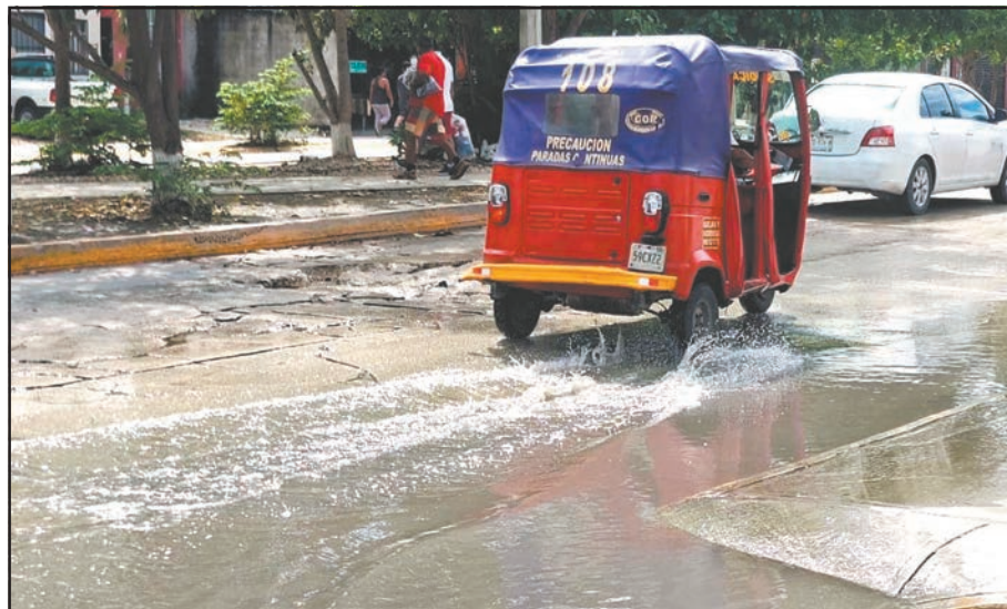
Familias del fraccionamiento Paraíso Maya demandaron reparar el derrame residual.
