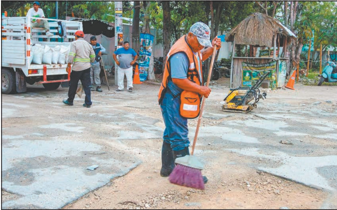
Algunos habitantes recordaron las obras de relleno realizadas con sus propios recursos. (POR ESTO!)
