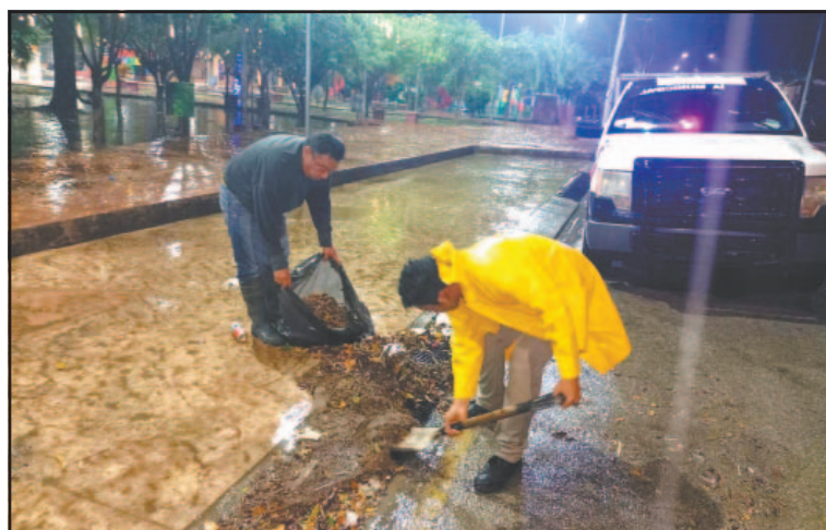
Personal de Servicios Públicos limpió el drenaje tapado. (R. Chan)
