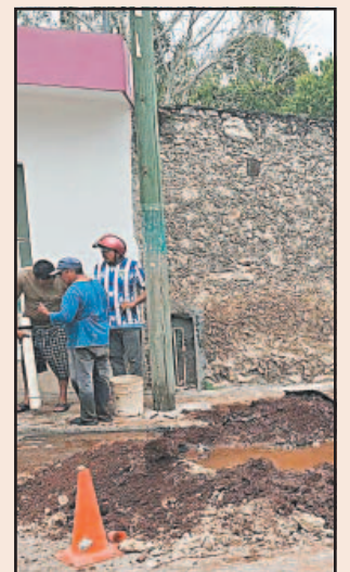
La reparación concluyó después de mediodía.
