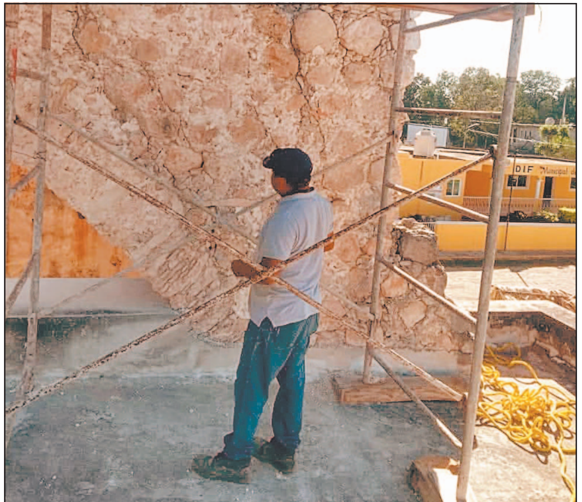
Las arduas labores de restauración se han centrado en la nave central con el resanado de las grietas.
