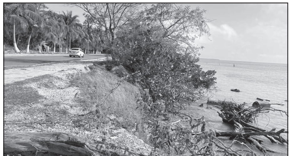
El peligro es evidente para quienes transitan a diario por el área. (Fotos Williams Duran)
