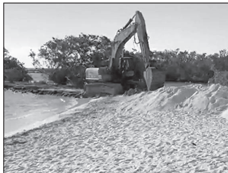
Maquinaria fue captada bloqueando la entrada al mar. (POR ESTO!)
