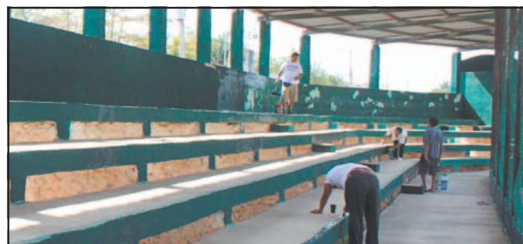
Trabajadores dieron mantenimiento al espacio público. (POR ESTO!)
