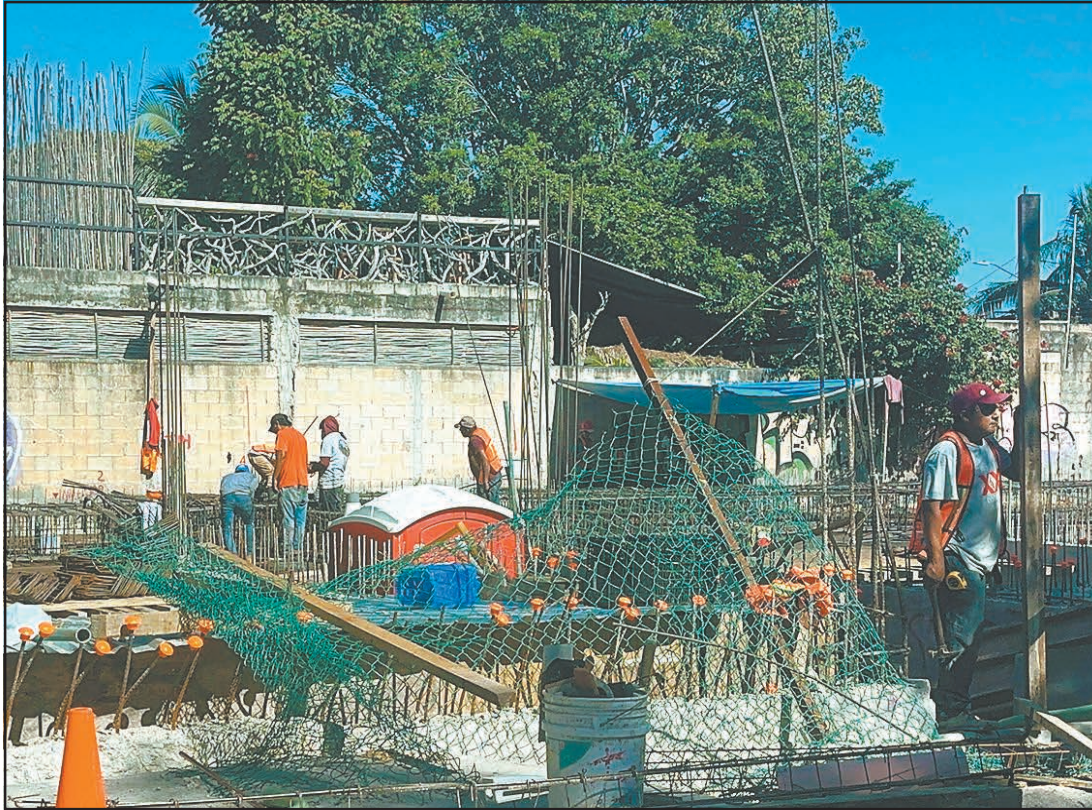
Se informó que la actividad de la construcción opera entre un 30 y 40% de su capacidad. (POR ESTO!)
