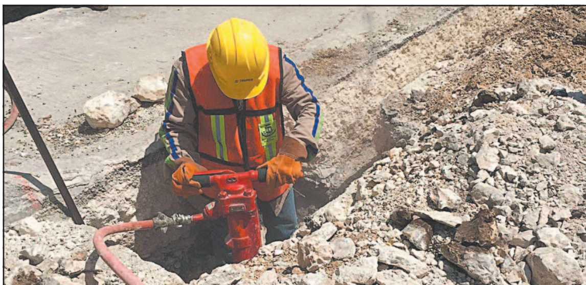
Autoridades construyen aljibes que permiten captar el agua de las precipitaciones y evitan inundaciones.
