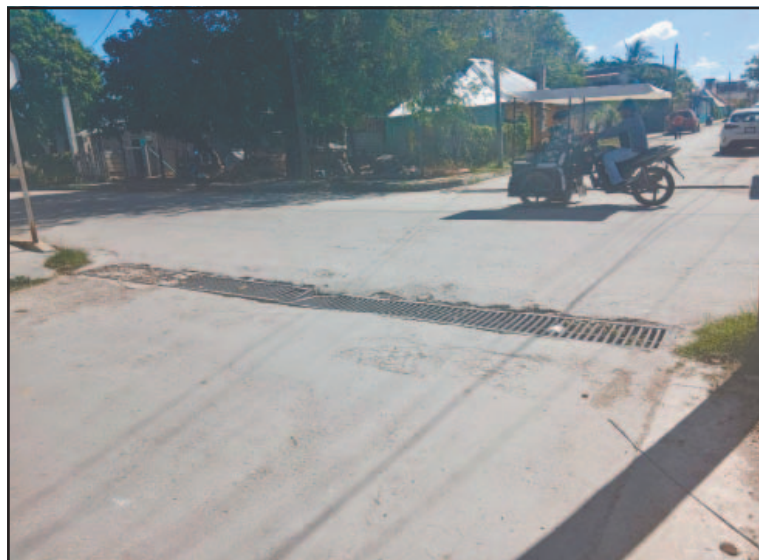
Las tapas se hunden al paso de los vehículos. (Joaquín Guevara)
