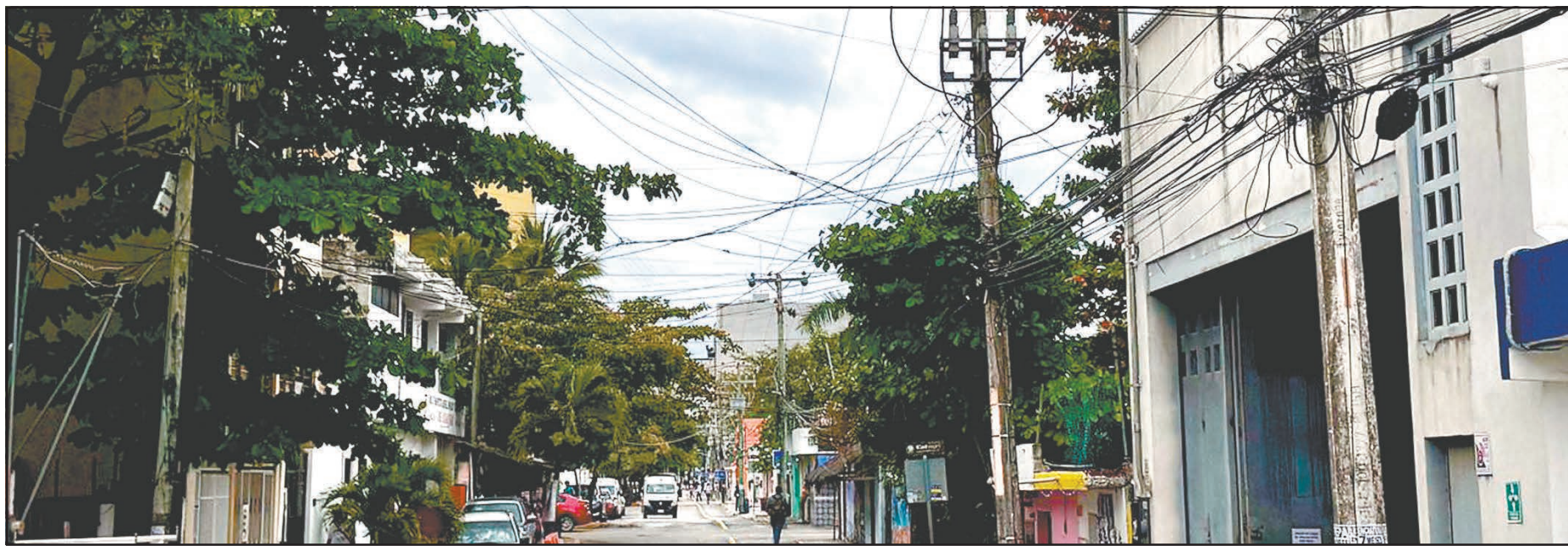
Fallas eléctricas golpearon a vecinos de colonias como Nicté-Há; residentes acusaron pérdidas, variaciones de voltaje y falta de respuesta efectiva de la CFE. (G. Escalante)
