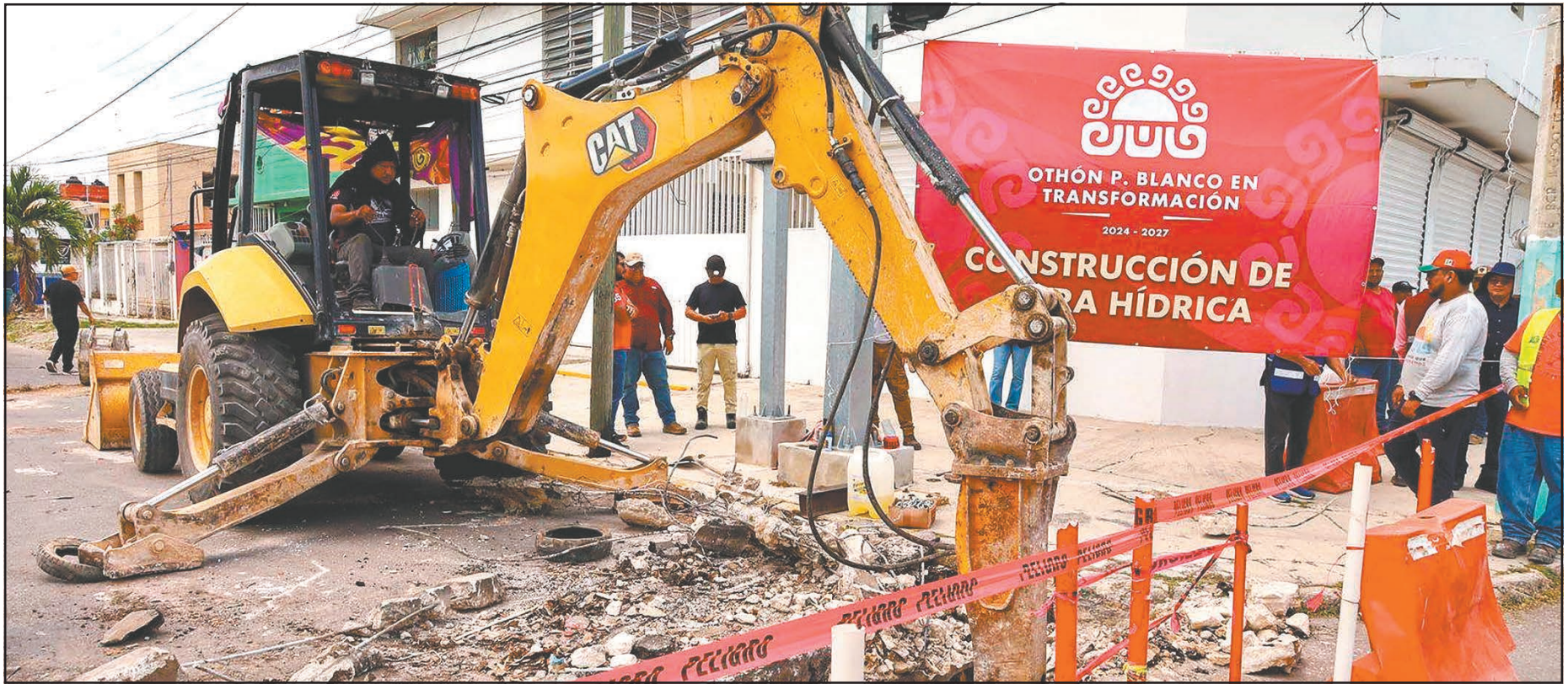
El proyecto contempla una intervención integral orientada a optimizar la captación y el desalojo del agua de lluvia mediante la sustitución de infraestructura existente. (POR ESTO!)
