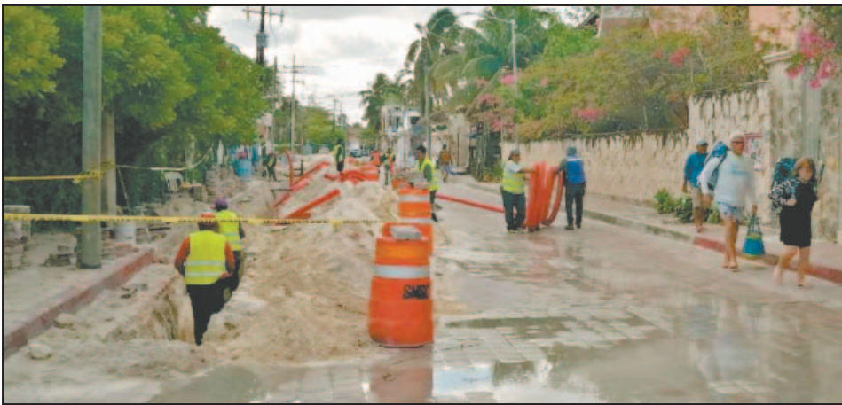
Se abrió una zanja de 150 metros desde la calle Carlos Lazo hasta Adolfo López Mateos.
