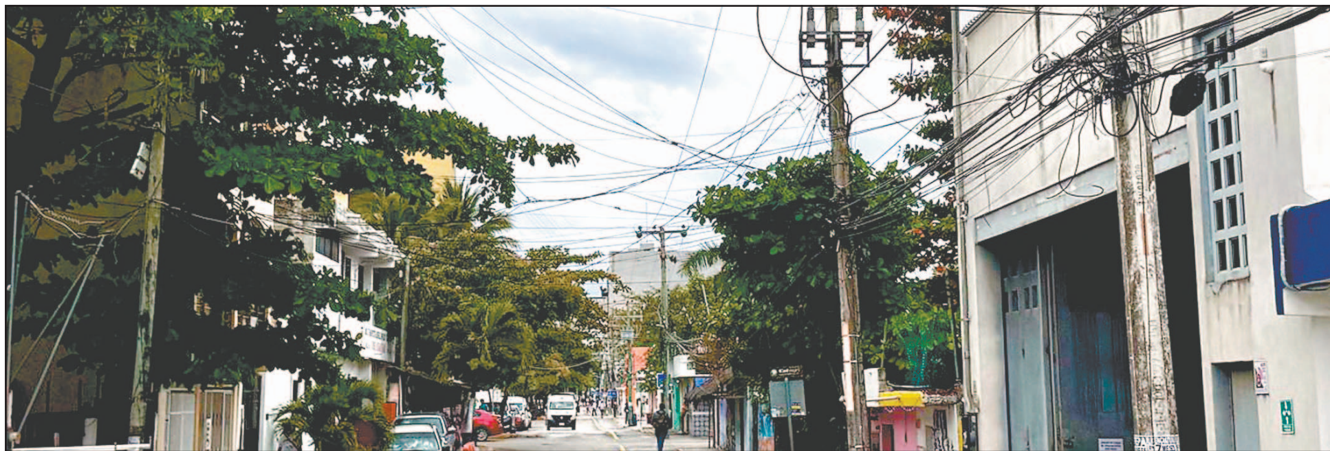
Fallas eléctricas golpearon a vecinos de colonias como Nicté-Há; residentes acusaron pérdidas, variaciones de voltaje y falta de respuesta efectiva de la CFE. (G. Escalante)
