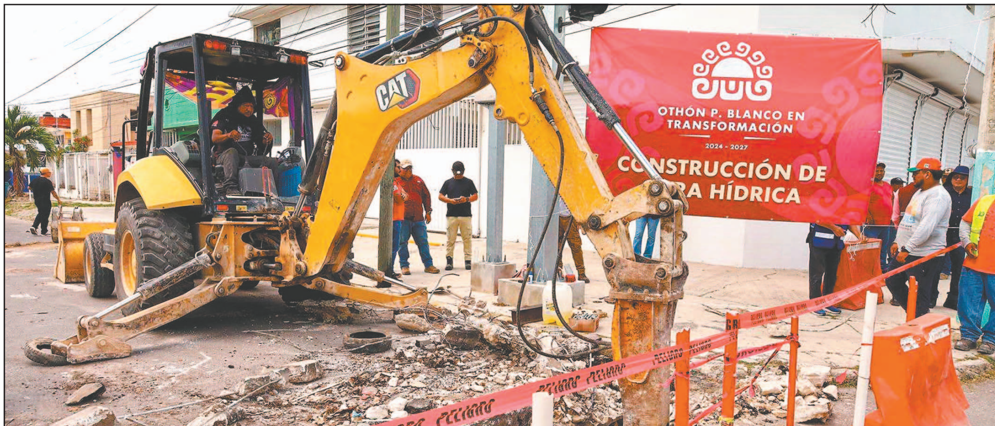
El proyecto contempla una intervención integral orientada a optimizar la captación y el desalojo del agua de lluvia mediante la sustitución de infraestructura existente. (POR ESTO!)
