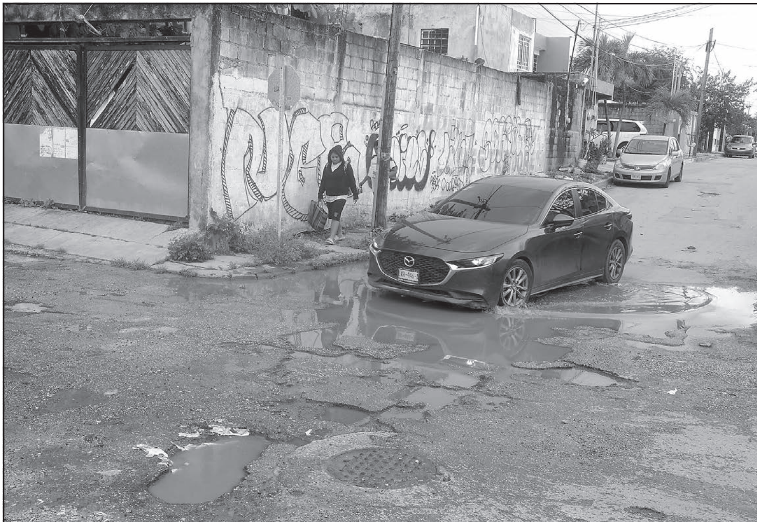
Los encharcamientos son comunes en cada esquina, además de que la señalética se encuentra dañada por el óxido. (Fotos Erick Romero)
