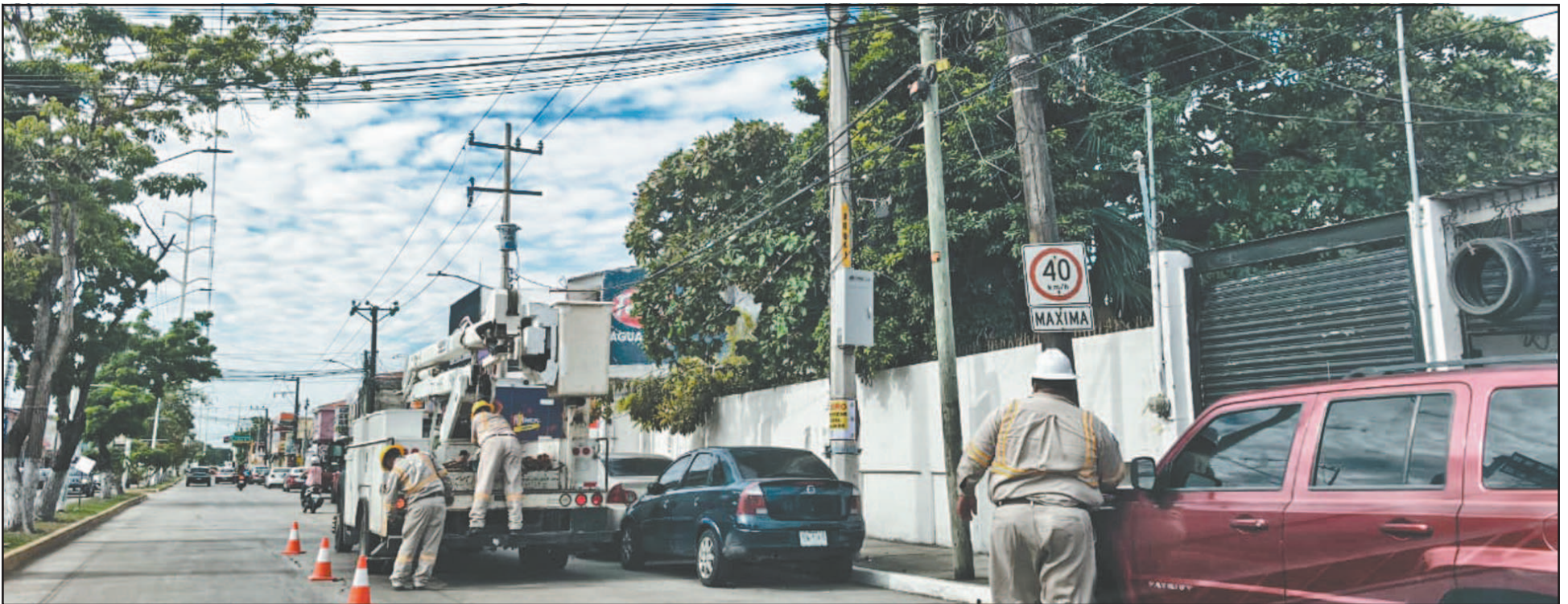
A fin de evitar que el recibo de la Comisión Federal de Electricidad llegue muy elevado, se recomienda aprovechar la ventilación natural en las "horas pico". (Perla Prado)
