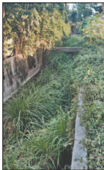
Lleva varios meses cubierto de hierba y con agua estancada.
