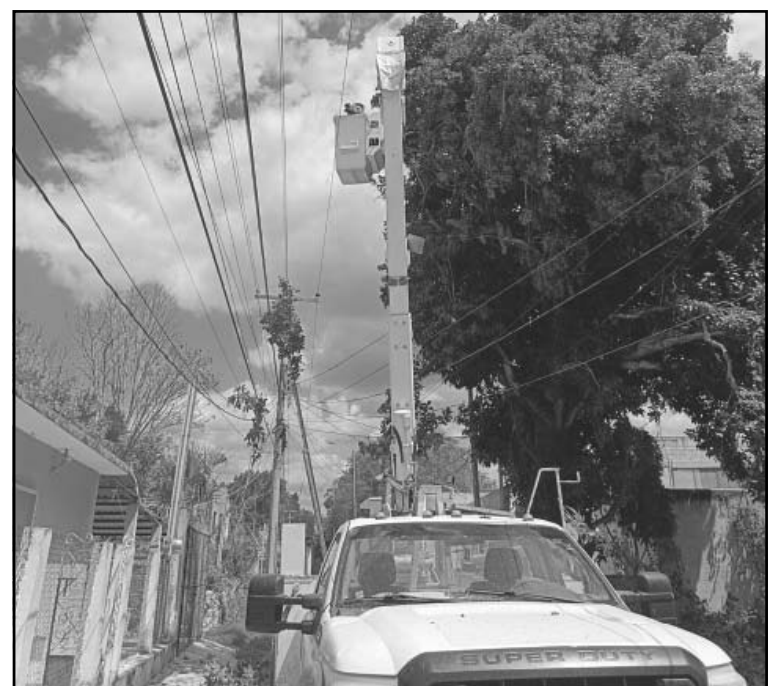
La empresa también podó los árboles cerca del cableado. (E. Caamal)
