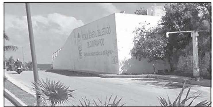
La empresa prometió ampliar la planta de tratamiento. (Ovidio López)
