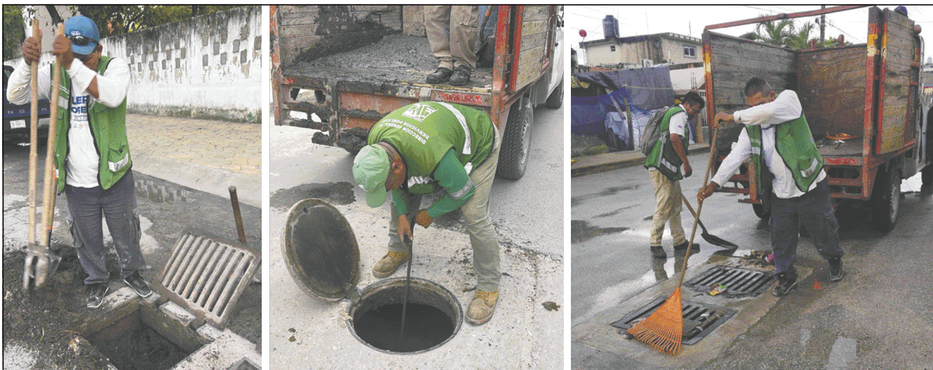
Trabajadores retiraron lodo y basura de la infraestructura hidráulica, con el fin de facilitar el flujo pluvial y evitar obstrucciones en las vialidades de la ciudad. (Fotos POR ESTO!)
