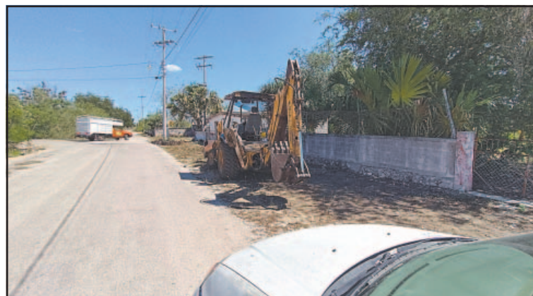
Entró maquinaria pesada al lugar para destruir plantas y construcciones.
