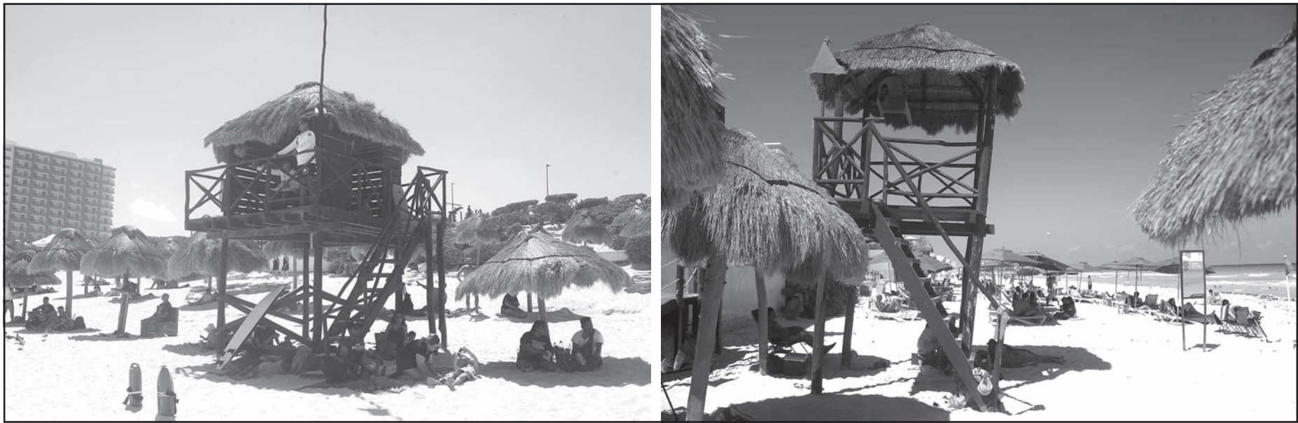
Vigilantes de las playas aseguraron que algunas zonas no cuentan con casetas para protegerse, otras están deterioradas del techo, escalones y barandales. (Erick Romero)
