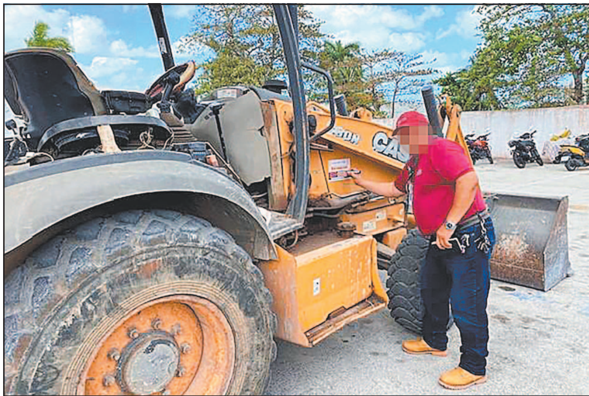
Autoridades detectaron una retroexcavadora trabajando a plena luz del día sobre una ciénega. (POR ESTO!)
