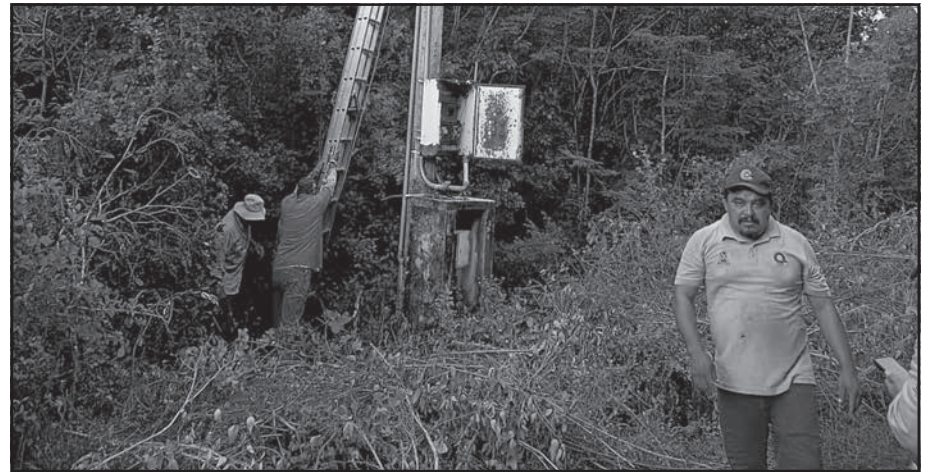
Indicaron autoridades que personal técnico labora en las reparaciones. (Fotos A. Blanco)
