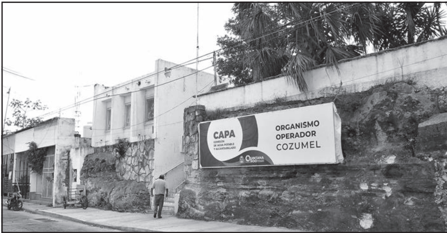
Afectados señalaron que la falta de suministro los ha obligado a comprar garrafones.
