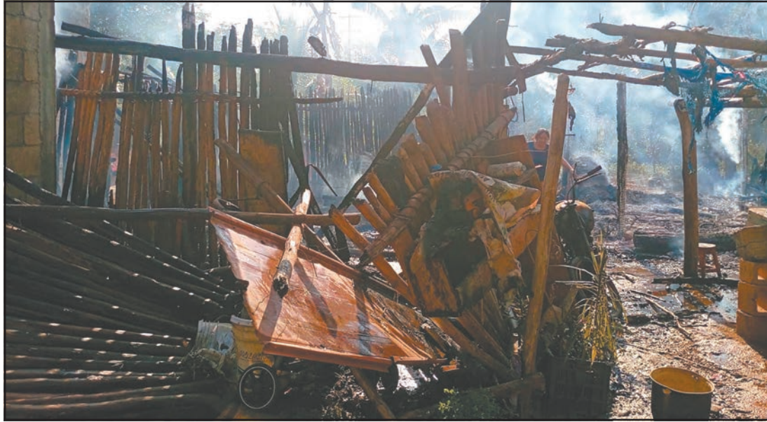
El inmueble fue consumido rápidamente, debido a que el techo estaba totalmente seco. (Fotos J. Xiu Chan)
