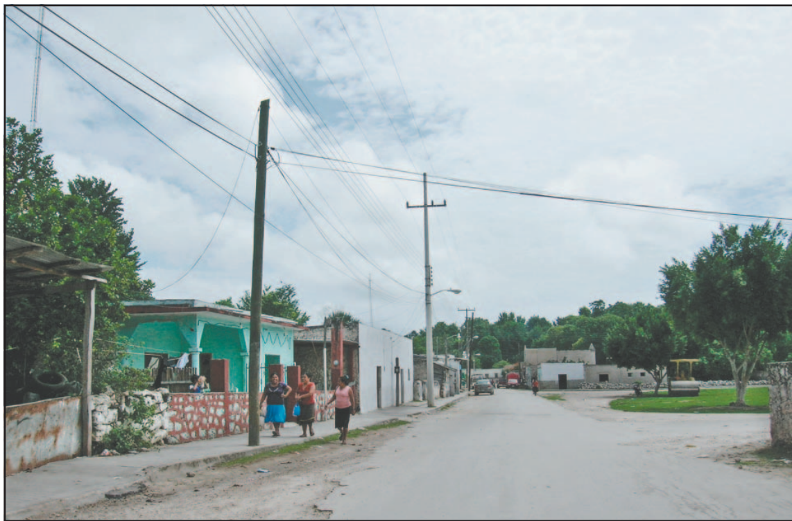
La falta de electricidad también provocó la suspensión del suministro de agua potable. (Mauriel Koh)
