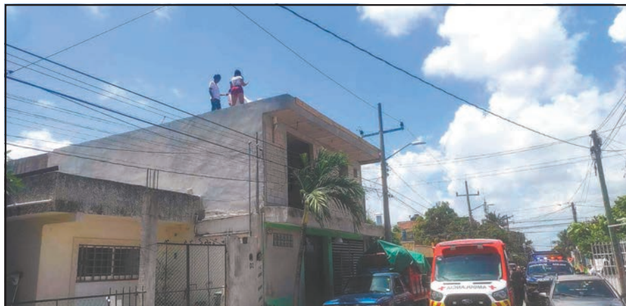
Bomberos notificaron de la situación a personal de la Comisión Federal de Electricidad.
