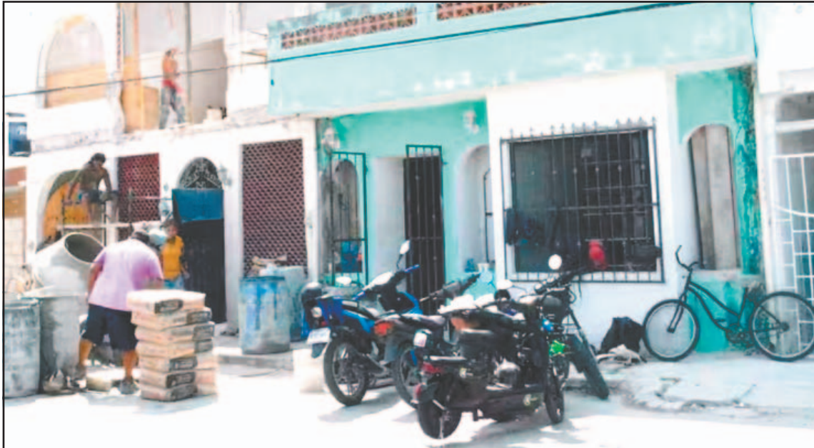
El alto costo por el traslado del material de construcción impide edificar unidades propias. (A. Blanco)
