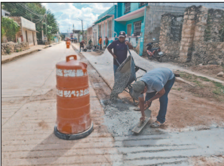
Los empleados hacen mezcla con palas, pues no tienen revolvedora.
