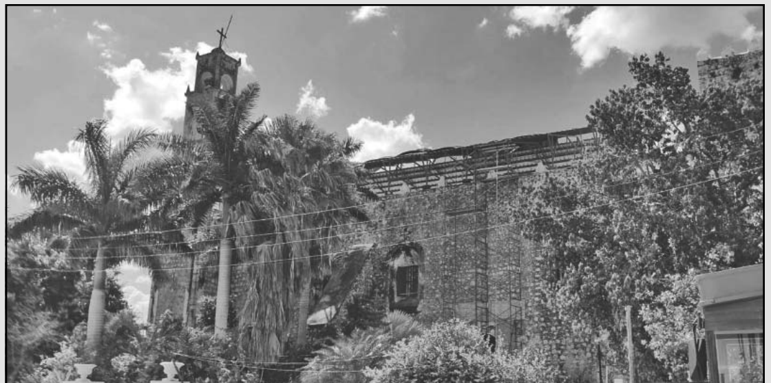
EL campanario atrae a los rayos y hay gente que en estos días realiza trabajos en el techo. (E. Caamal)
